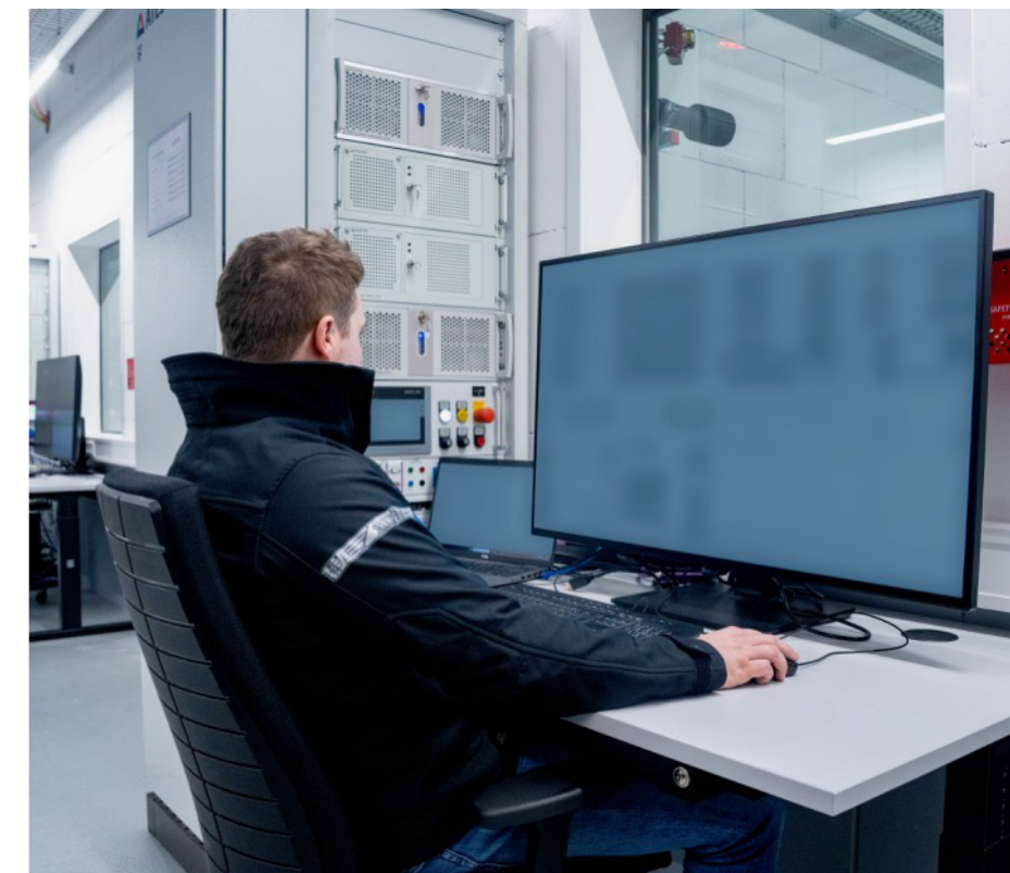
▶ 試験ベンチ制御室
